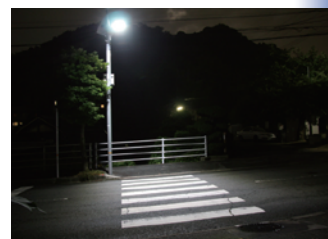
■LED ダウンライト 蛍光灯と比較して全体的に明るくなり、消費電力も少ない。
